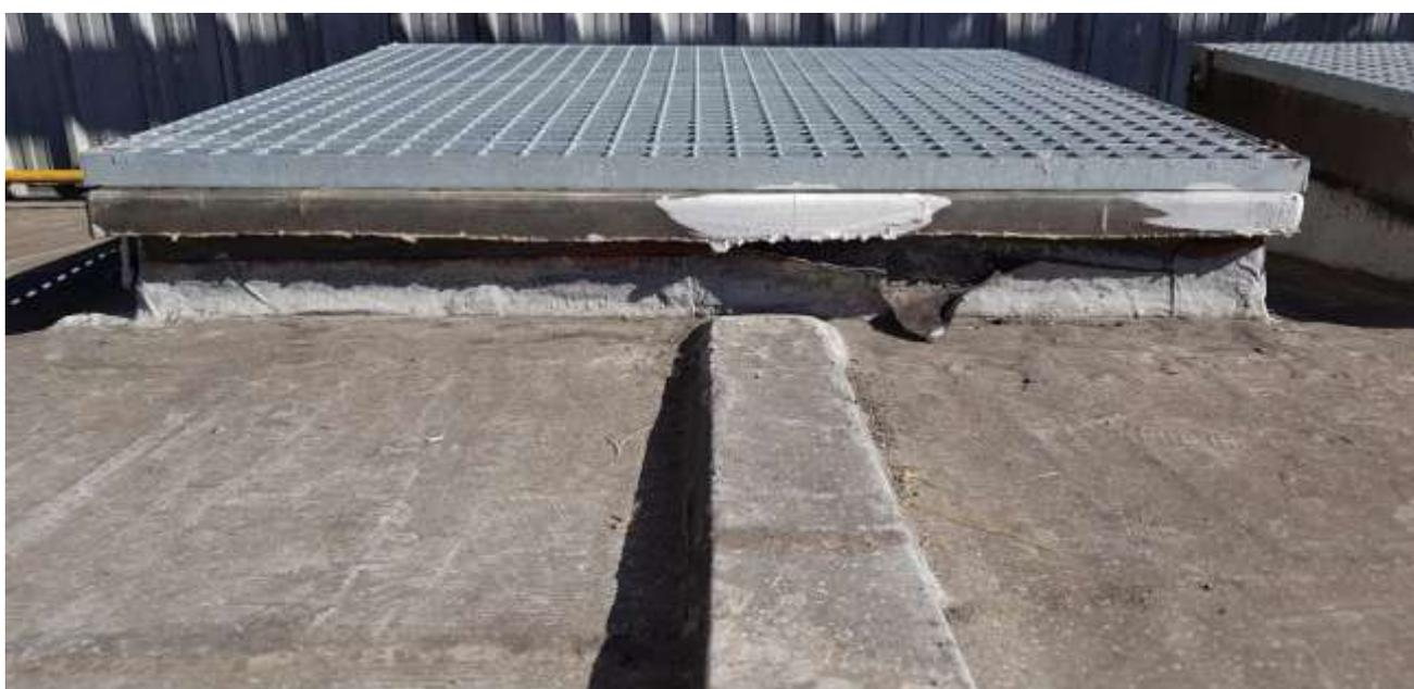
Tras la limpieza y preparación de la superficie, retirando los restos de recubrimientos anteriores que no han dado resultado y han terminado por levantarse, se empezaron las actuaciones para la fabricación con **Sistema Termoplástico Mansillas (STM)** de todo el perímetro de los lucernarios para su impermeabilización, el primer paso fue la aplicación de primer, como puente de unión antes de fabricar el **STM**.
