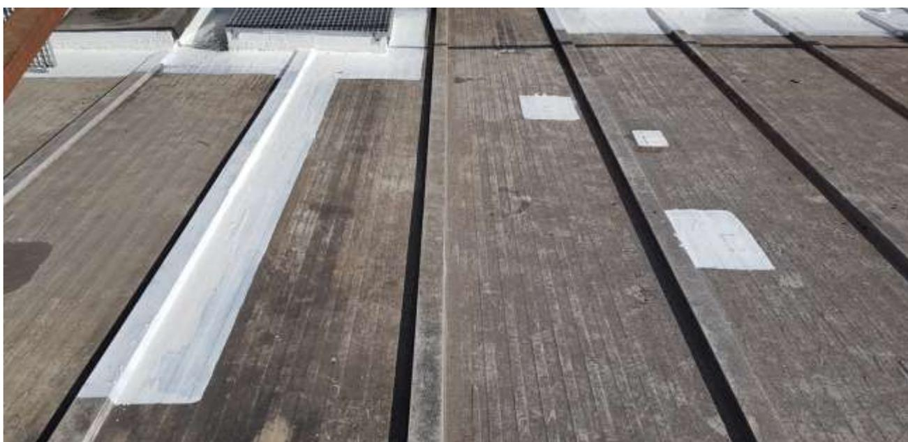
Detalle de la impermeabilización de los lucernarios y varias zonas más de la cubierta.
