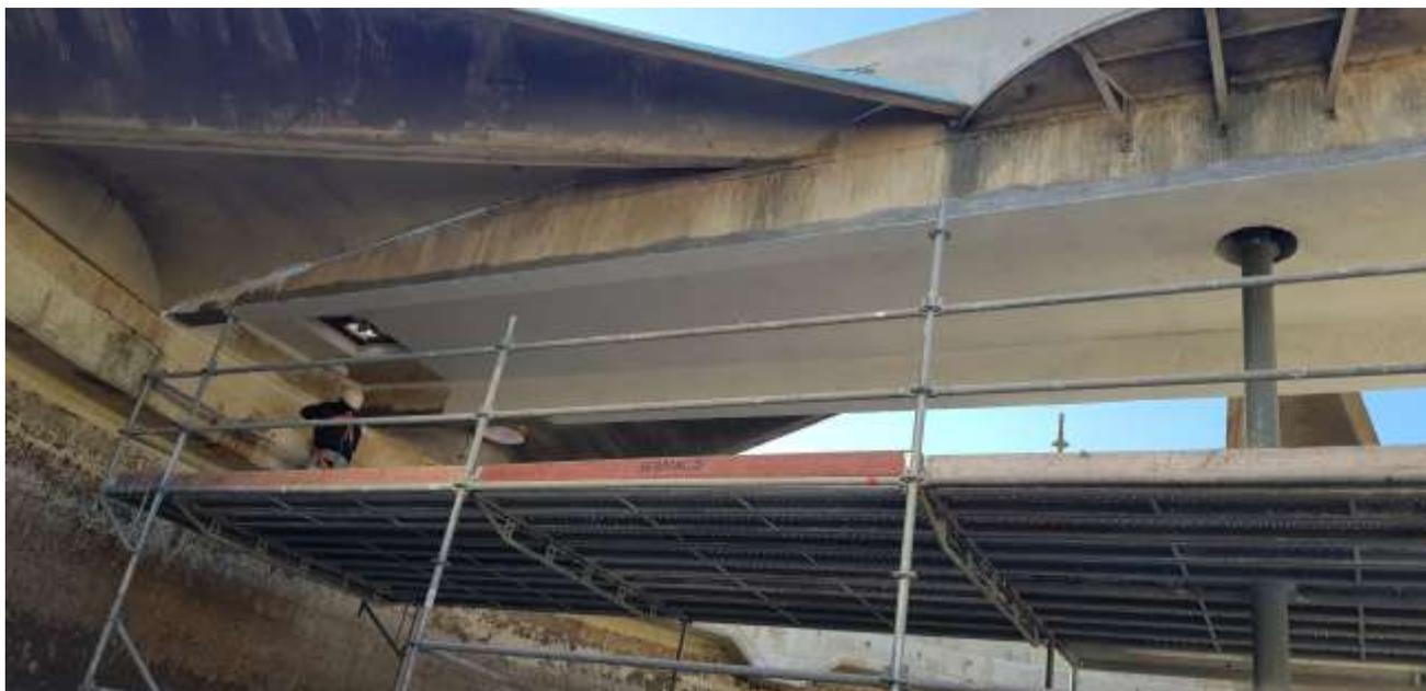
Finalizando con la fabricación de una nueva pasarela o armadura protectora con el **Sistema Termoplástico Mansillas (STM)** in situ, con fábrica autónoma y sin necesidad de parar la actividad de esta instalación durante mucho tiempo, debido al escaso tiempo de curado del **STM**.
