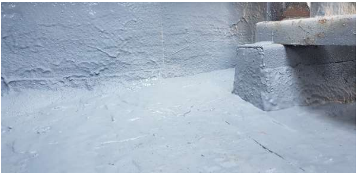
Detalle de la nueva cubierta una vez fabricada con STM.
