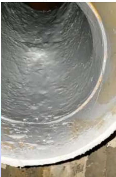
Codo de bajante reparado con la fabricación del **STM**
