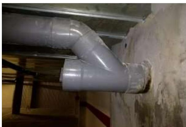
Estado inicial del codo de bajante donde se aprecia la rotura.
