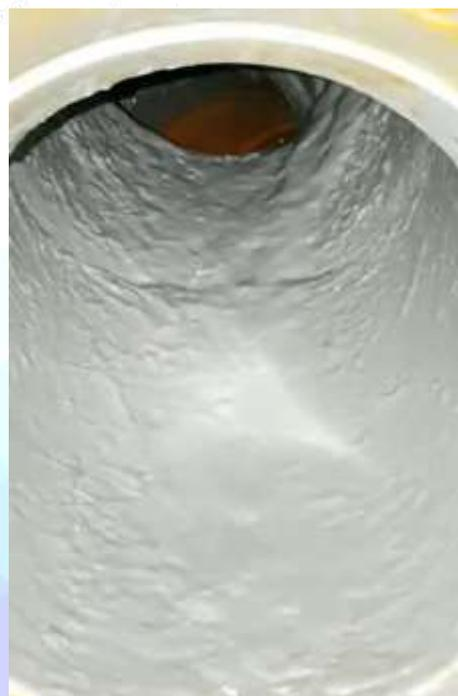
*Con el Sistema Termoplástico Mansillas hemos creado un nuevo codo de bajante por el interior del existente con las mismas dimensiones pero con una resistencia y durabilidad mayor.*
