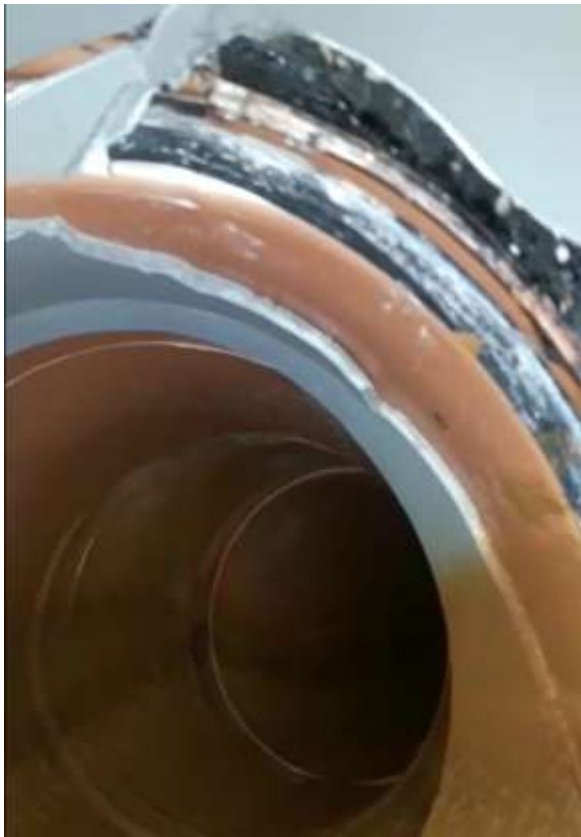
Etat initial du coude de tuyau de descente avec la rupture.
