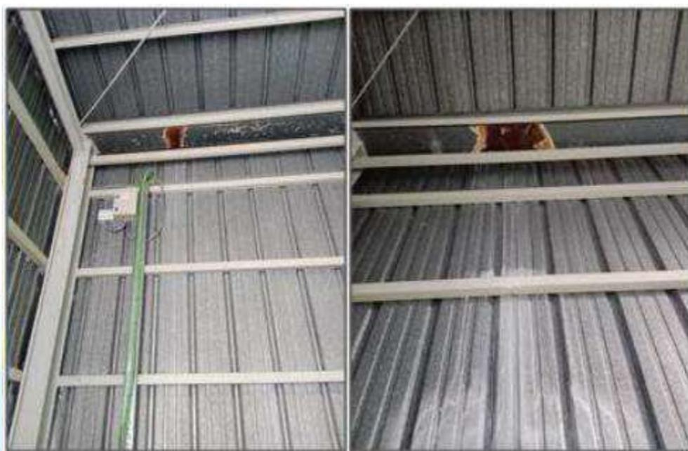
La corrosion par piqure et perte de section qui a causé des fuites.
