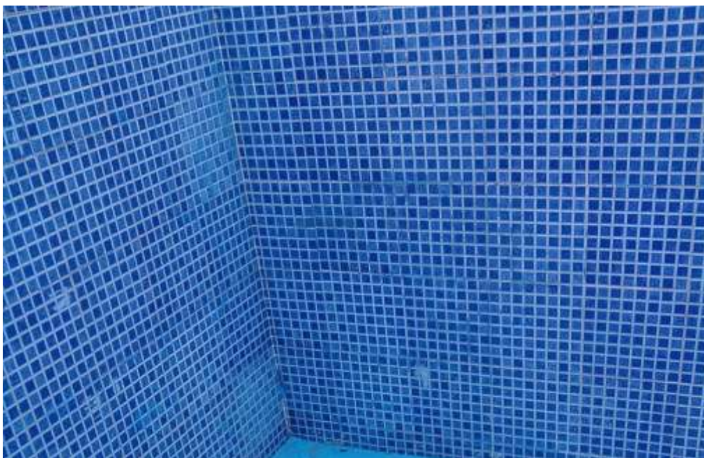
Detalle de la superficie a rehabilitar
