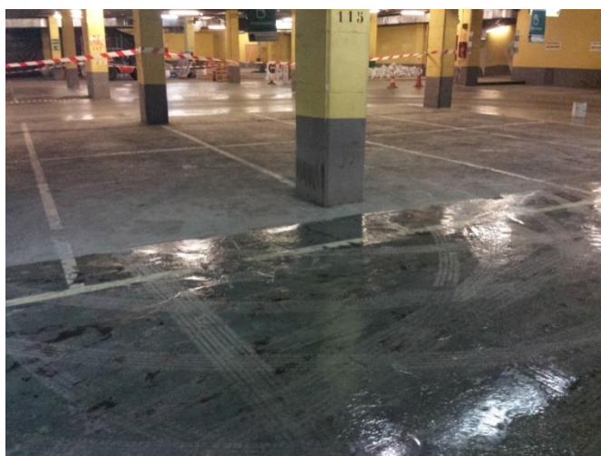
Nettoyage, ponçage et préparation de surface
