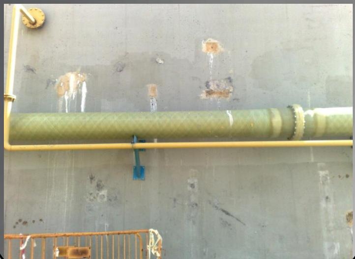
6º. Revestimientos avanzados. Fabricación de base estanca en el interior con revestimientos avanzados, mediante plastificado de la superficie interior de forma continua fabricándose los vasos interiores estancos en una sola pieza. Con estos sistemas implantados por el interior el agua (del interior del muro) se expulsaba por el exterior del decantador debido a la presión de los vasos fabricados desde el interior.
