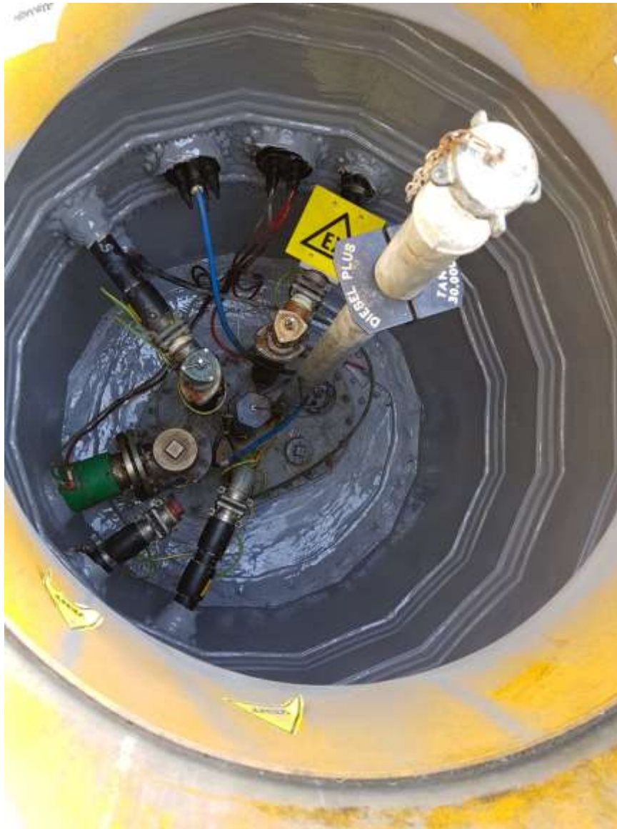
L'intérieur du bassin collecteur après la fabrication du STM
